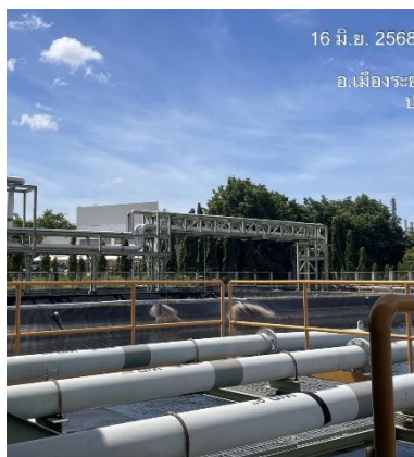
ภาพที่ 2-7 การเดินท่อและติดตั้งปั๊มเพื่อนำน้ำทิ้งจากกระบวนการผลิตมาใช้ใหม่
