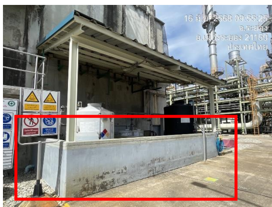
ภาพที่ 2-26 คันคอนกรีตป้องกันการหกรั่วไหลของสารเคมี
