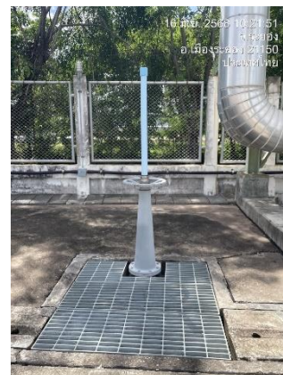
ภาพที่ 2-12 ประตุน้ำทิ้งและน้ำฝนของโครงการ
