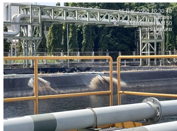
ภาพที่ 2-7 การเดินท่อและติดตั้งปั๊มเพื่อนำน้ำทิ้งจากกระบวนการผลิตมาใช้ใหม่
